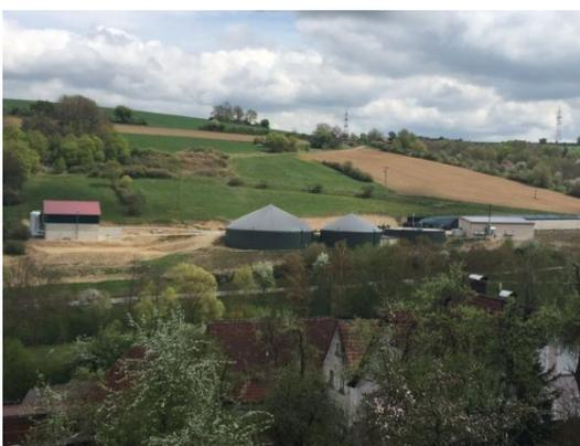
durch die interessierten Einwohner startete der Bau des Nahwärmenetzes sowie der Übergabestationen im Sommer 2014. Im Herbst begann die Errichtung der Hackschnitzelanlage zur Spitzenlastabdeckung in den Wintermonaten. Aus Effizienzgründen wurde zusätzlich ein Pufferspeicher mit 44.000 l Inhalt installiert. Die seit 23.12.2014 in Betrieb befindliche Anlage versorgt auf umweltfreundliche und energieeffiziente Weise mittlerweile
