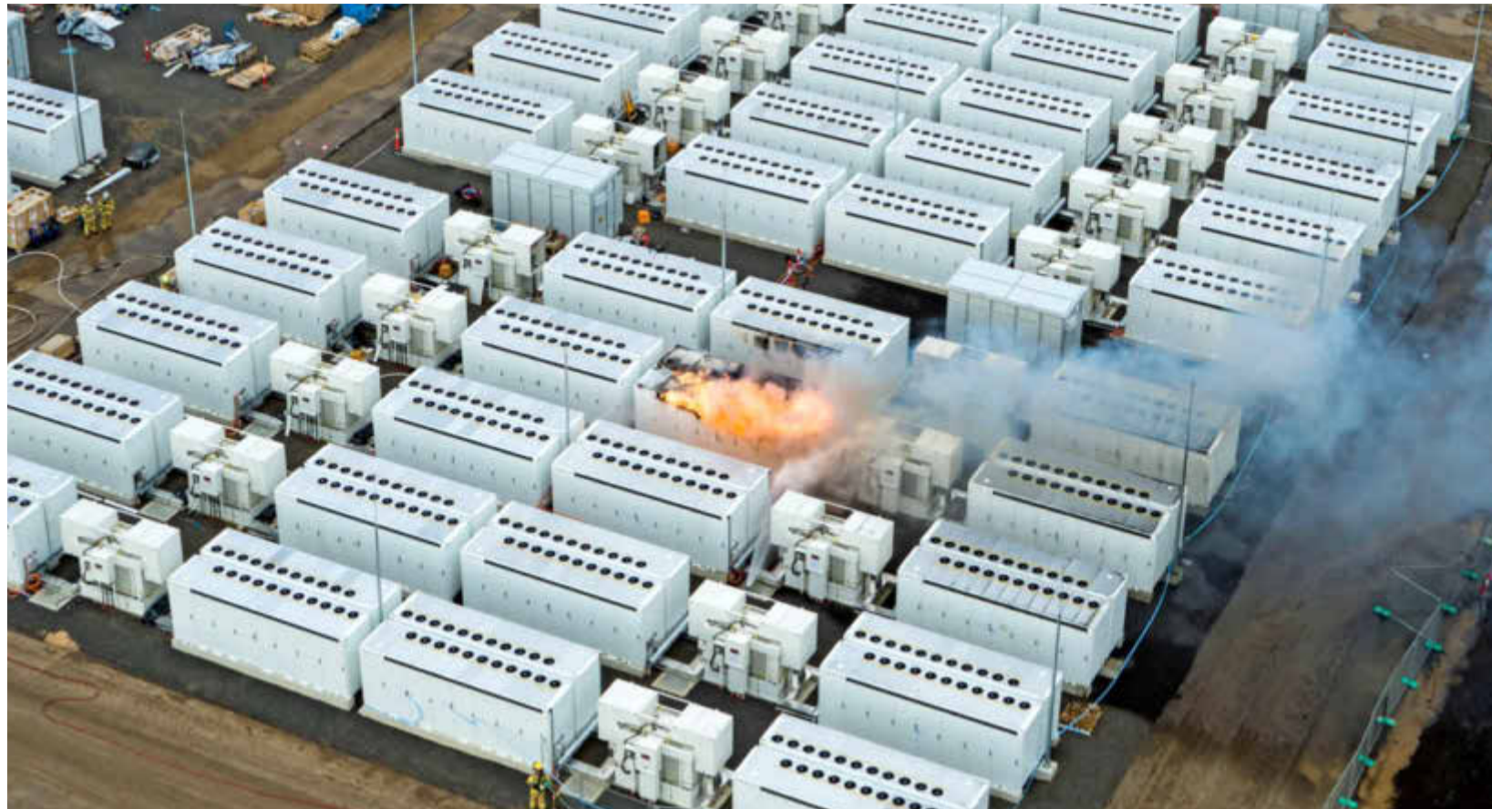
Ein spektakuläres, aber sehr unschönes Bild: Im Zug der baldigen Inbetriebnahme einer 300-Megawatt-Anlage von Tesla fing eine Zelle Feuer. Foto: AFP Photo/Fire Rescue Victoria
