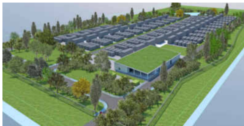
Wie die Tesla-Anlage im australischen Bundesstaat Victoria soll der Kupferzeller Netzbooster in Container-Bauweise entstehen. Visualisierung: Transnet
