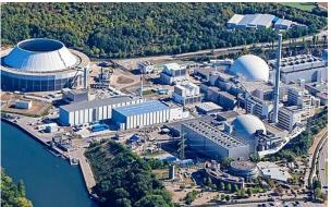
Auf dem Gelände des Atomkraftwerks Neckarwestheim laufen schon die Abrissarbeiten. Dafür wurden eigens die langgestreckten Hallen am Neckarufer errichtet.
