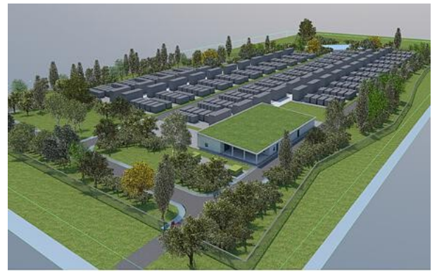
Und so könnte er einmal aussehen: Die Visualisierung des Projektierers zeigt die Ausführung in einer Container-Bauweise. Visualisierung: Transnet
