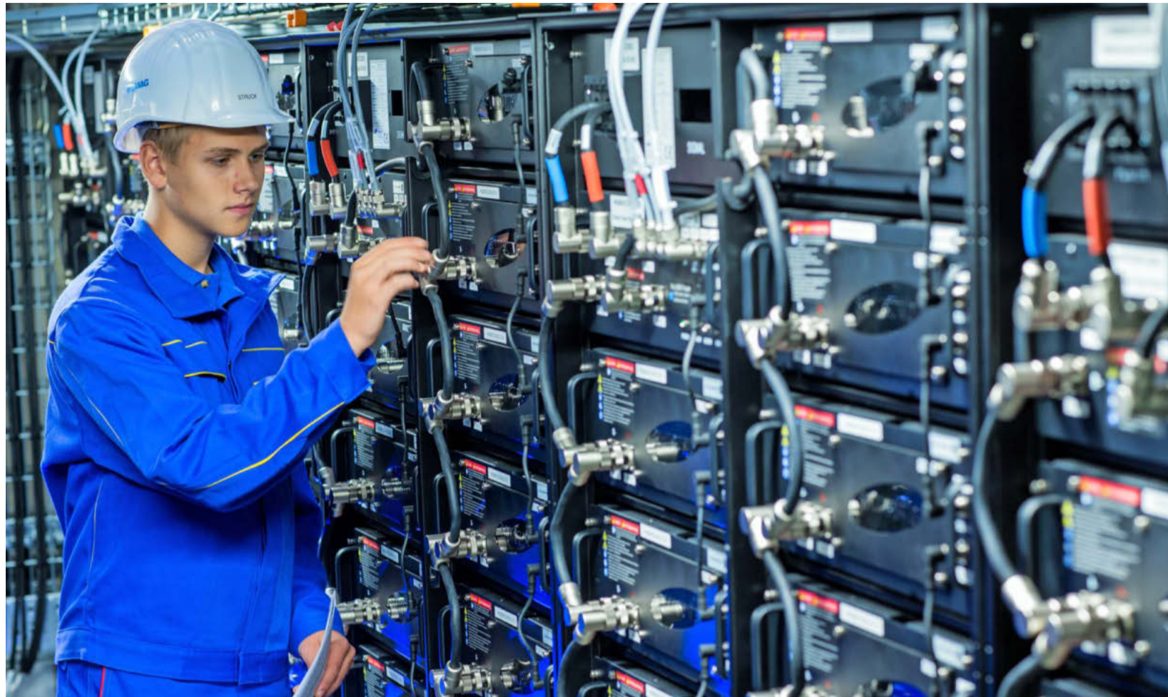
Innenansicht eines Batteriespeichers: So oder so ähnlich könnte es irgendwann auch im Kupferzeller Netzbooster aussehen.
